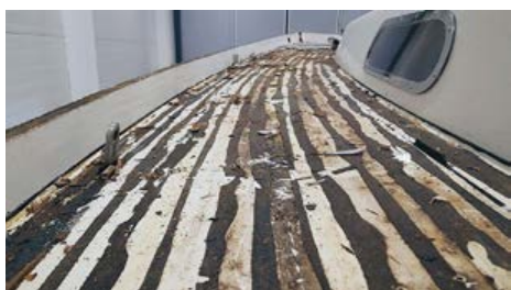
Avrivet däck, de gula fällningarna mellan silikonen visar på vatten
