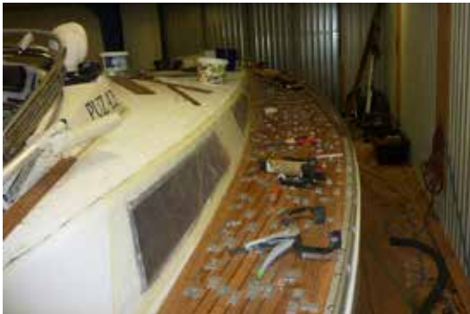
3. Teakribborna läggs ut på däck, limmas ihop och fixeras med skruv och aluminiumbrickor. Alla ribbor sågas till för exakt passning.
