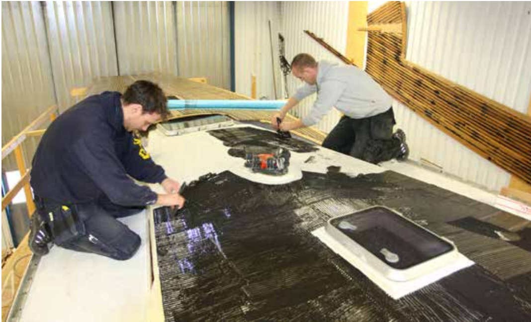
4. Limning av rufftaket pågår. Hela ytan påstryks med särskilt lim. Rufftakssektionen skymtar i fören av båten. Den kommer strax att fixeras på sin exakta plats på däck. På väggen hänger fortfarande babords längsgående sektion.
