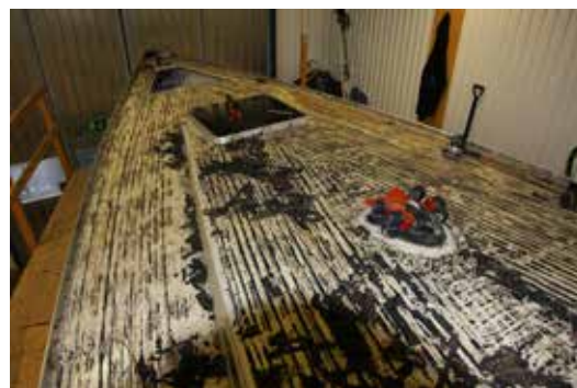
1. Alla teakribbor borttagna. Kvar är limrester som ska slipas bort.
