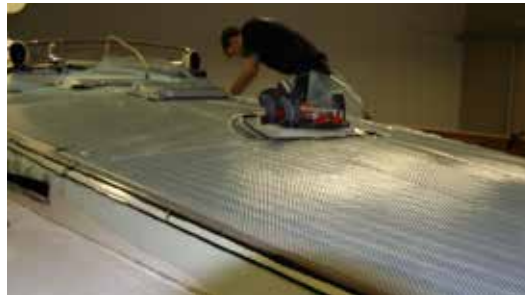
5. Förberedelse för vakuumsugning av rufftakssektionen. Nät och plast läggs över däck och tätas med butylband runt om. Sedan skapas ett tryck på däck på ca 8 kg/m 2 som får limmet att fördela sig jämnt mellan däck och teak utan risk för framtida läckage.
